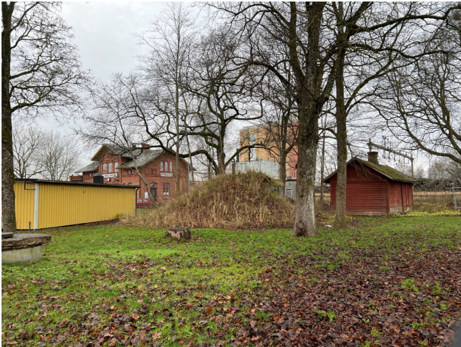
Foto på stationshuset och omkringliggande byggnader, vissa av dem kulturhistoriskt värdefulla.
