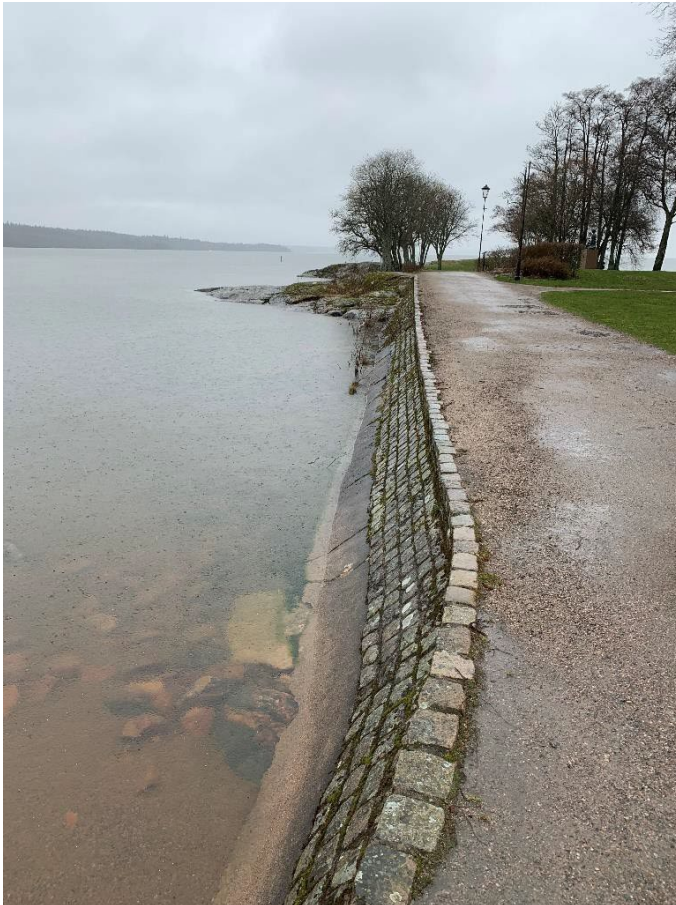
Figur 3. Undervattensgjutning i släntfot.
