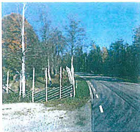
Fastighetsanslutning med dålig sikt
