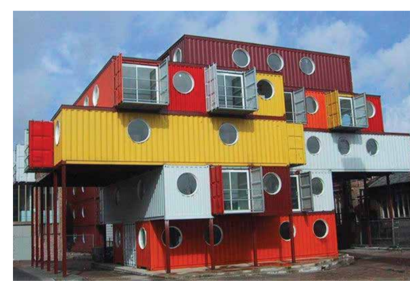
Bostäder i London byggda med containers, med möjlighet till påbyggnad
