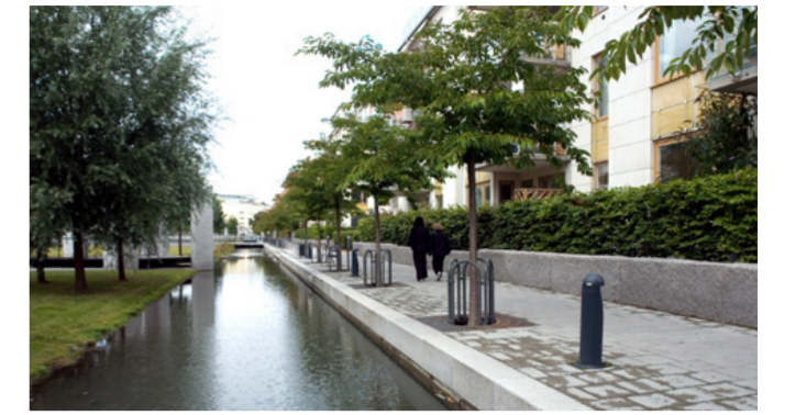
Dagvattenkanal, exempel från Hammarby Sjöstad. Foto Olle Robin.
