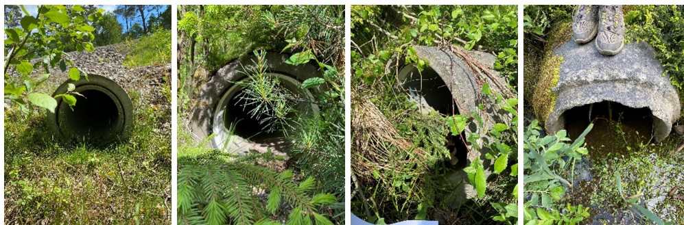
Figur 7 Första fotot (1) visar trumman under den enskilda vägen mot Svevia Bergtäkt medan foto nr 2–4 visar dagvattentrummorna under väg 697 för väst-öst. Vid nr 1 och 2 är marken torr men nr 3 och 4 så är den blötare. Dimensionerna på dessa två är större än vid nr 1 och 2.
