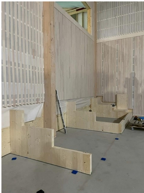
Uppbyggnad av läktaren i idrottshallen med monterad spaltpanel på väggarna.
