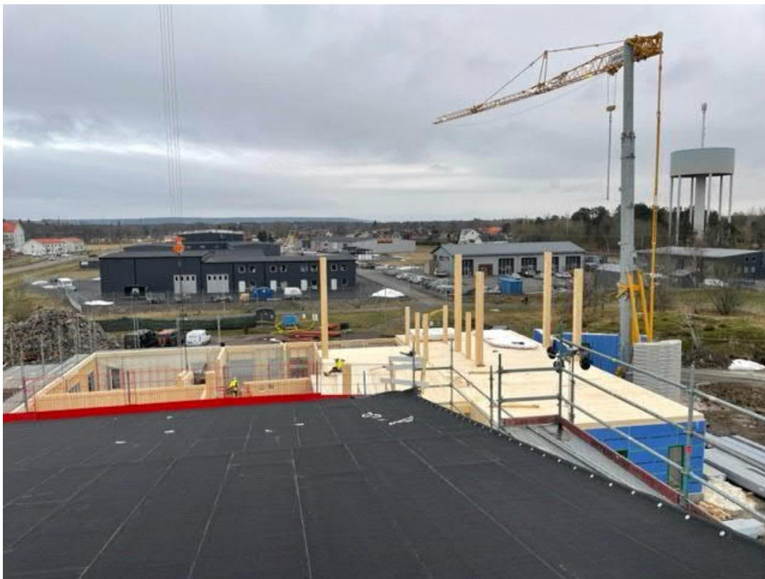
Pågående stommontage på Hus 4.
