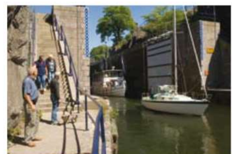
Slussning i Trollhätte kanal
