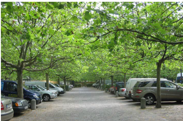
Permeabel markbeläggning och skuggande trädrader förbättrar avsevärt dagvattenhanteringen och skapar en mildare mikroklimat som bland annat sänker temperaturerna i de parkerade bilarna. Foto: Johan Östberg
