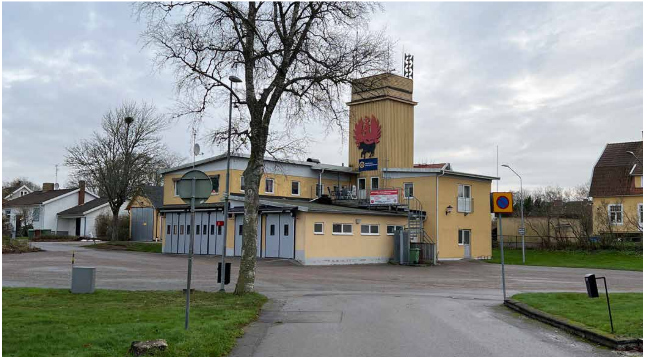
Brandstationen. Den första etappen uppfördes redan 1926. Successiva utbyggnader och förändringar har gjorts under åren. Idag präglas den av en blandning av funktionalism och modernism. Det bevarade spruttornet från 1926 är om än ombyggt ett värdefullt kännetecken. Källeberg 10:8.
