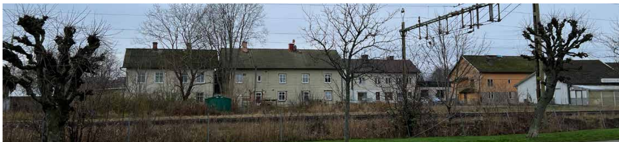
Bebyggelse vid Järnvägsgatans norra del.
