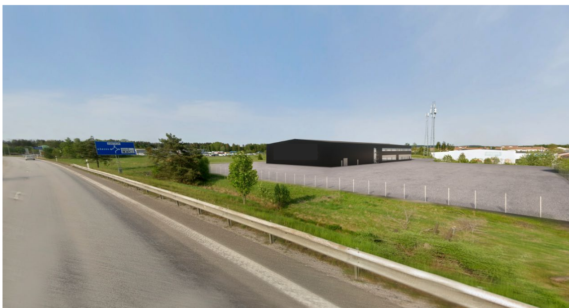
Illustrerad byggnad sedd från väg 2026 utan expansion.
