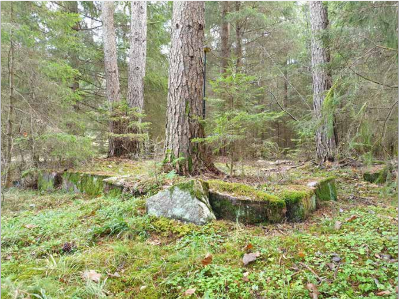
Figur 12. Stengrunden A1276 är fortfarande helt synlig ovan mark.
