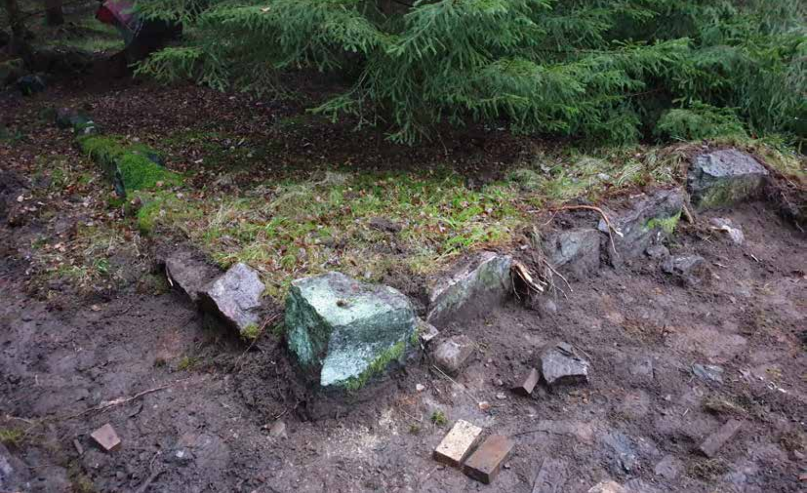
Figur 9. Stengrunden i det nordvästra hörnet av husgrund A1210.
