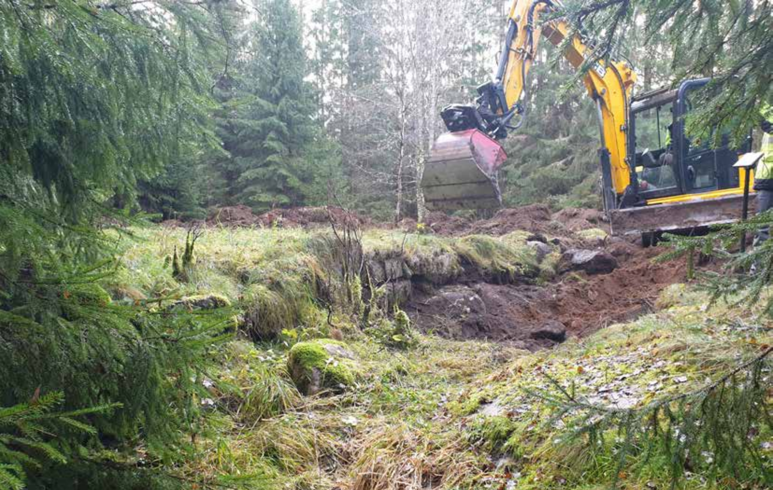
Figur 3. En husgrund schaktas fram.
