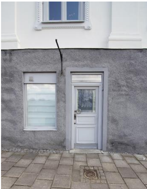
Den tidigare portalen mot Hamngatan byggts igen och ersatts med en dörr och ett fönster. Ankarjärn och källarfönster med smidesgaller är ursprungliga detaljer.
