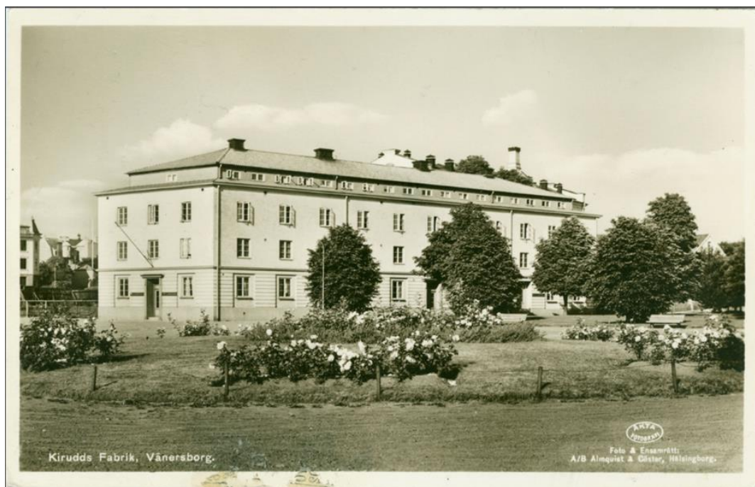
Vallmon med ursprungligt säteritak. Bortsett från att man förändrat taket har byggnaden i stort kvar sitt ursprungliga uttryck.
