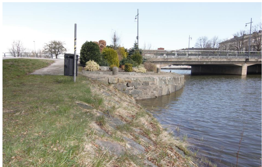
Kanalsidan på Sanden är uppbyggt av ett sluttande murverk som troligen är ursprungligt då äldre pållare står med jämna mellanrum längs hela sträckan. Innanför finns ett promenadstråk med träd på ena sidan.
