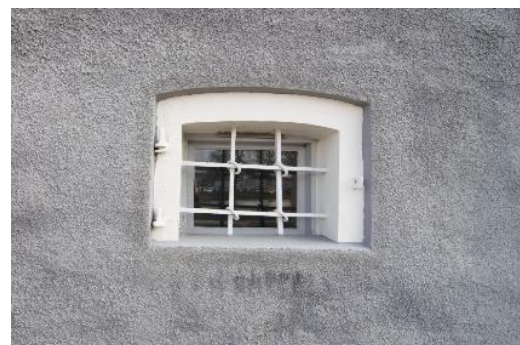
Den tidigare portalen mot Hamngatan byggts igen och ersatts med en dörr och ett fönster. Ankarjärn och källarfönster med smidesgaller är ursprungliga detaljer.
