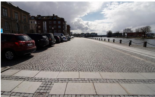
Hamngatans gatubeläggning sett från Sundsgatan söder ut mot stationshuset.
