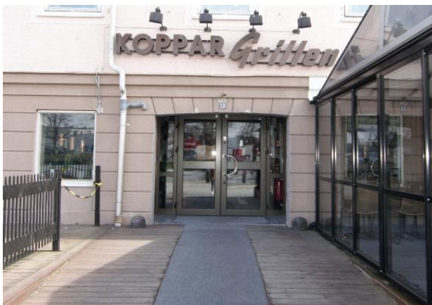
Framför entrépartiet finns idag en ramp som delvis skymmer de gamla pällarna som placerats vid sidan om portalen.
