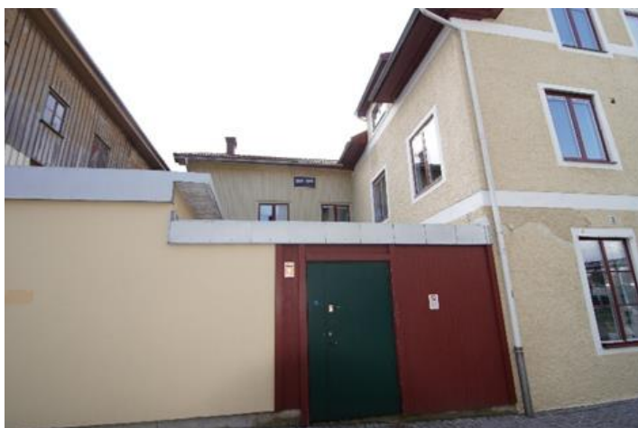
Plank och små komplementbyggnader inhägnar fastigheten. Här syns tillbyggnaden som ännu är panelbeklädd, ett spår av att byggnaden ingått i stadens småskaliga trähusbebyggelse.
