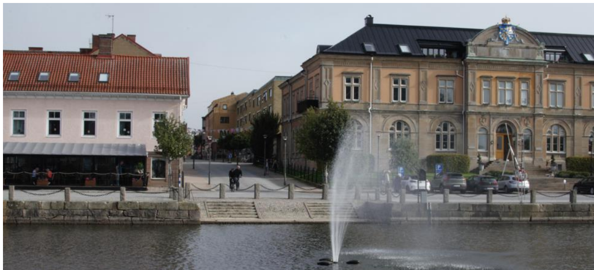
Vid lågvatten kan man se vissa skillnader mellan murverket norr och söder om Sundsgatan då dessa är uppförda i olika etapper.
