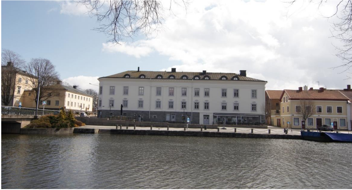
I sockelvåningen mot Hamngatan finns idag restaurang och caféverksamhet med uteserveringar. Andra och tredje våning är inredda med lägenheter.
